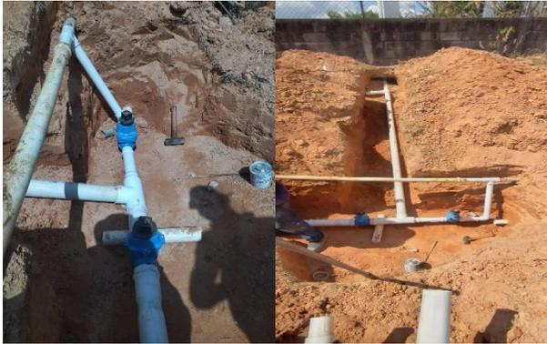
**INSTALACION DE TUBERIA, LLAVE, REDUCCION, CODO, EXCAVACION. RELLENO.**
