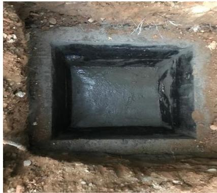
**FORMALETIADA Y FUNDIDA DE CAJA DE INSPECCION**
