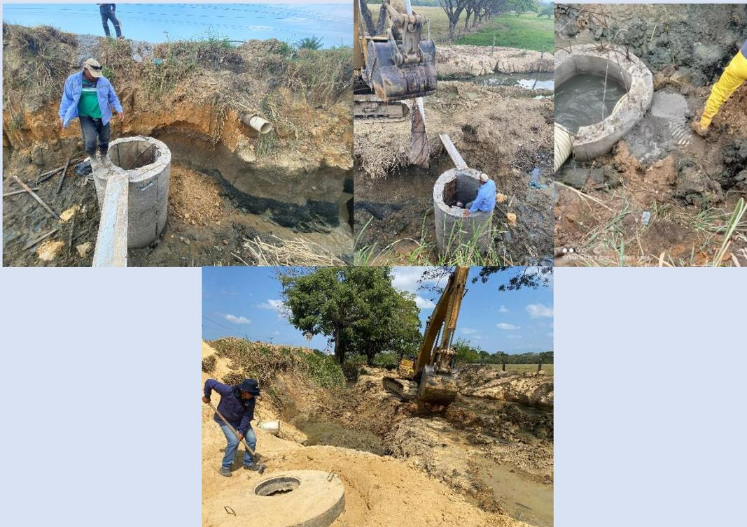
**REPARACION DAÑO DE ALCANTARILLADO EN EL BARRIO SAN VICENTE, EN EL CUAL SE PROVOCO UN HUNDIMIENTO DE LA VIA DEBIDO A LAS FUERTES LLUVIAS**
